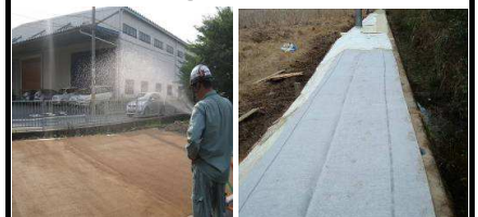
散水養生 マット養生
