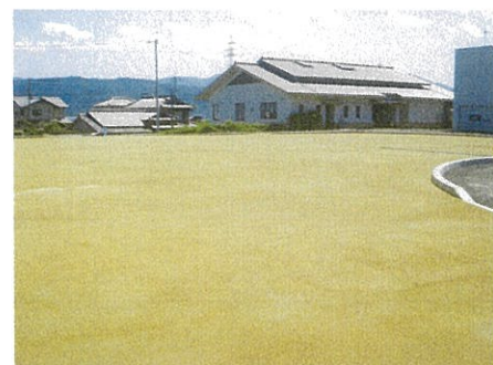
阿波市防災センター (徳島県阿波市)
