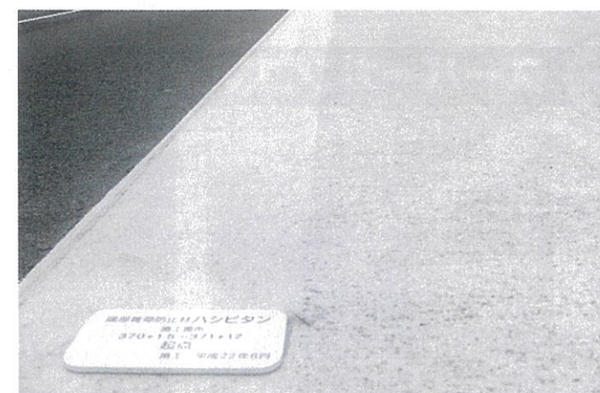
国道 32 号中央分離帯 表層工 [コンクリート] 完成 (香川県善通寺市)
