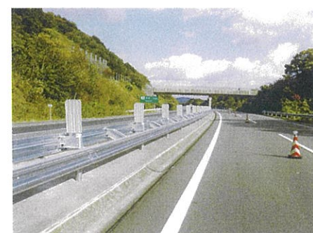
神戸淡路鳴門自動車道
