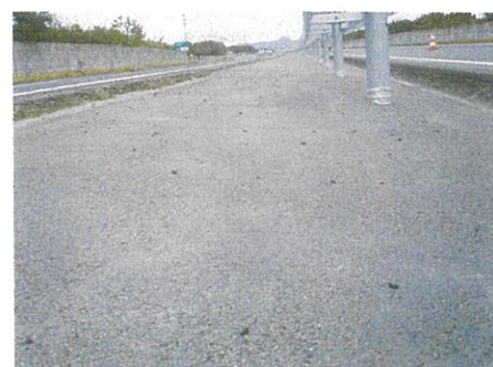
神戸淡路鳴門自動車道
