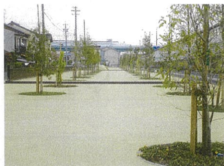
名古屋国道 23 号 (愛知県)
