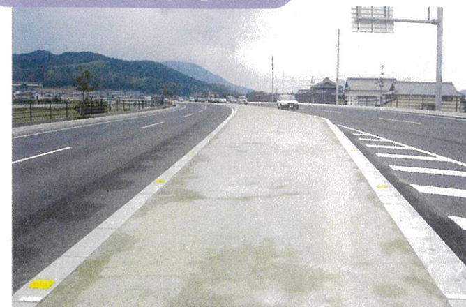
中央分離帯ガンコマサ端部 (香川県綾歌町)
